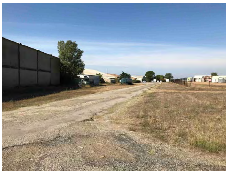
Cliché E : Vue depuis la limite est du projet des lignes de hangars 1 et 2.
