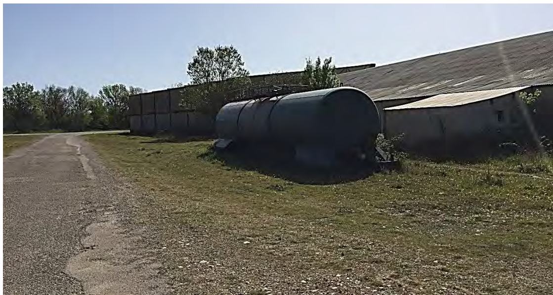
Photographie 8 : Citerne incendie au niveau des hangars de l'aérodrome de Salon-Eyguières
