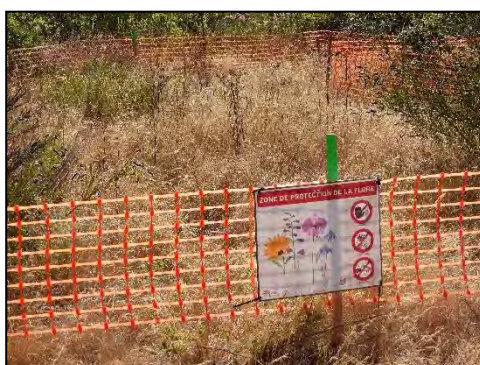
Mise en défens par balisage avec une résille de chantier et un panneau indicatif
