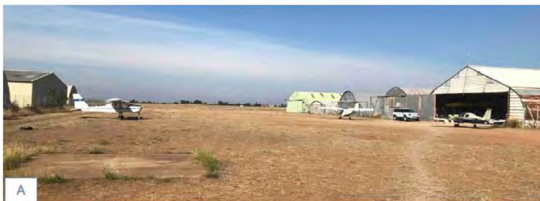
Photographie 13 : Cliché A - Vue des lignes 1 et 2 des hangars actuels depuis le centre du terrain
