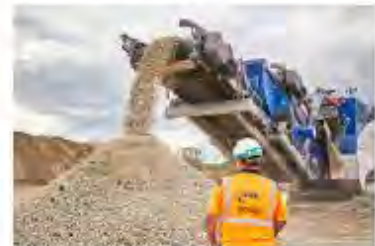
▲ La plateforme de valorisation des déchets située à Martignas-sur-Jalle a été l'une des premières créées dans le Groupe. Ici, campagne de concassage.
