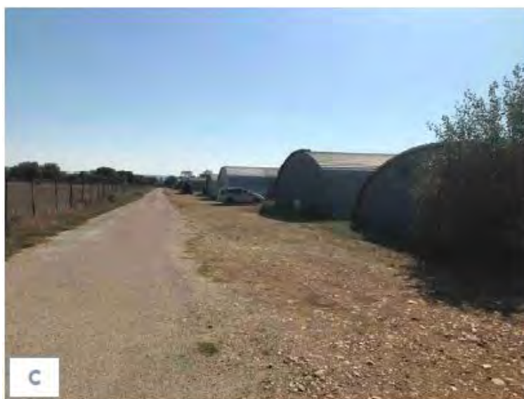
Photographie 15 : Cliché C - Vue depuis la limite nord du projet de la dernière ligne de hangars, la n°3
